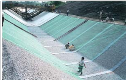
FIG. Nº 20-4.- Canal de planchas ensambladas de ferrocemento
